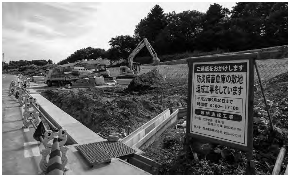
防災備蓄倉庫の整備に向け進む工事
