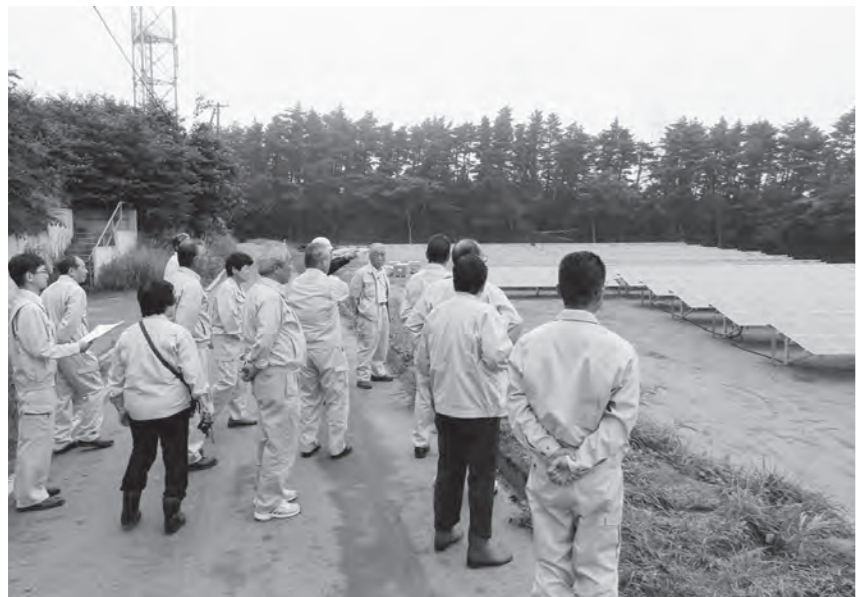
メガソーラー発電建設現場を視察
