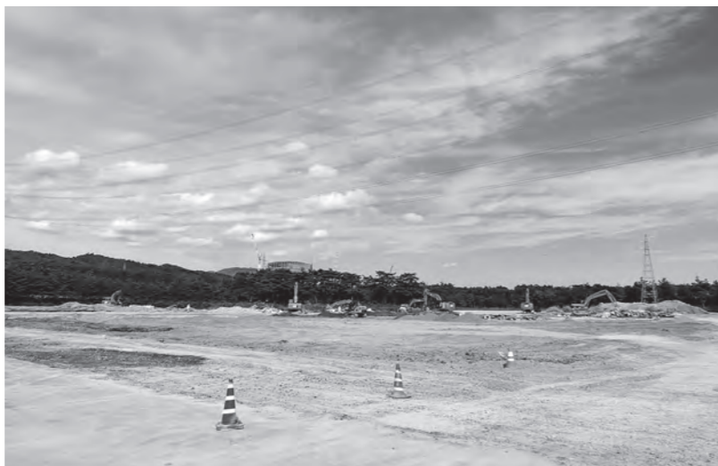
三豊広野工場建屋等解体工事の様子
