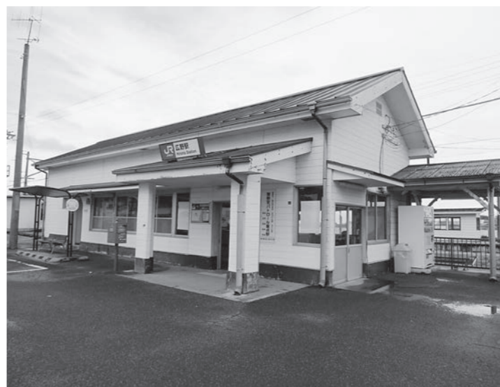
整備が求められている広野駅舎
