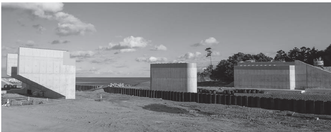
県事業の橋梁下部工は完成
