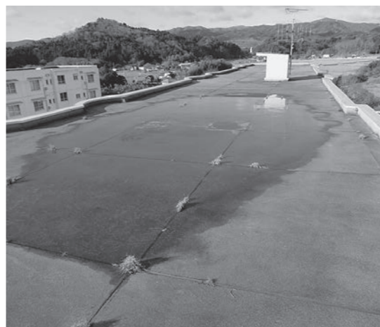
屋上の防水修繕も実施
