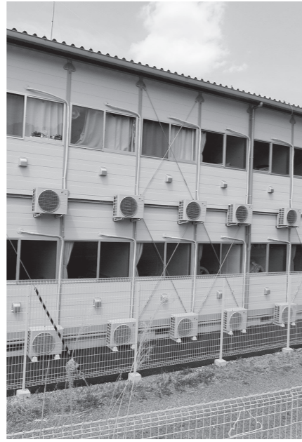
町内に建設されている作業員宿舍
