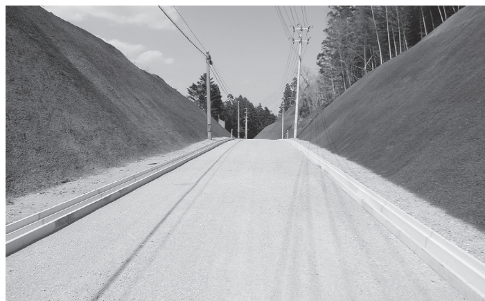
新しい道路を整備しています（北沢・東下線）
