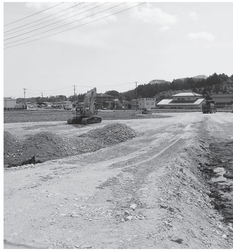
災害公営住宅を整備する大平地区
