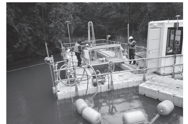
平成27年度に実施した「ため池除染」の様子
