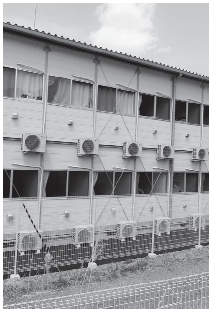
町内に建設されている作業員宿舍
