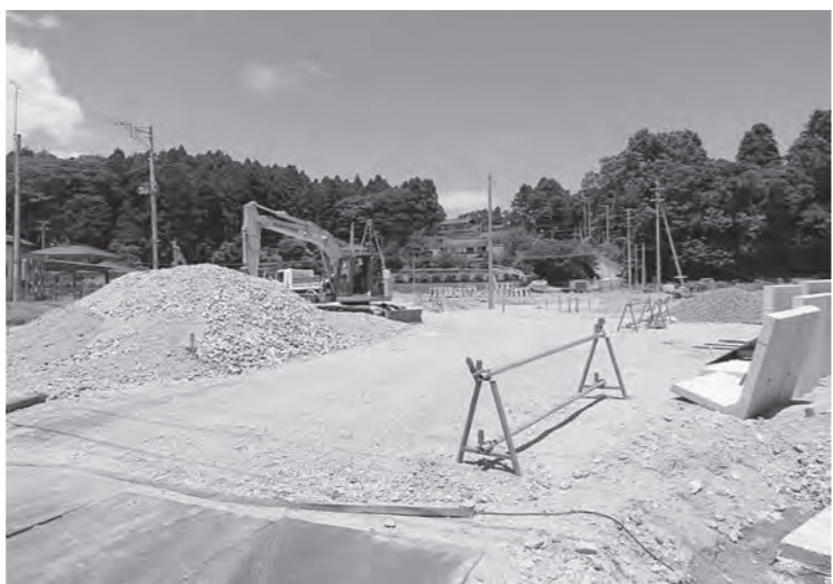
整備が進む第2期災害公営住宅（大平地区）
