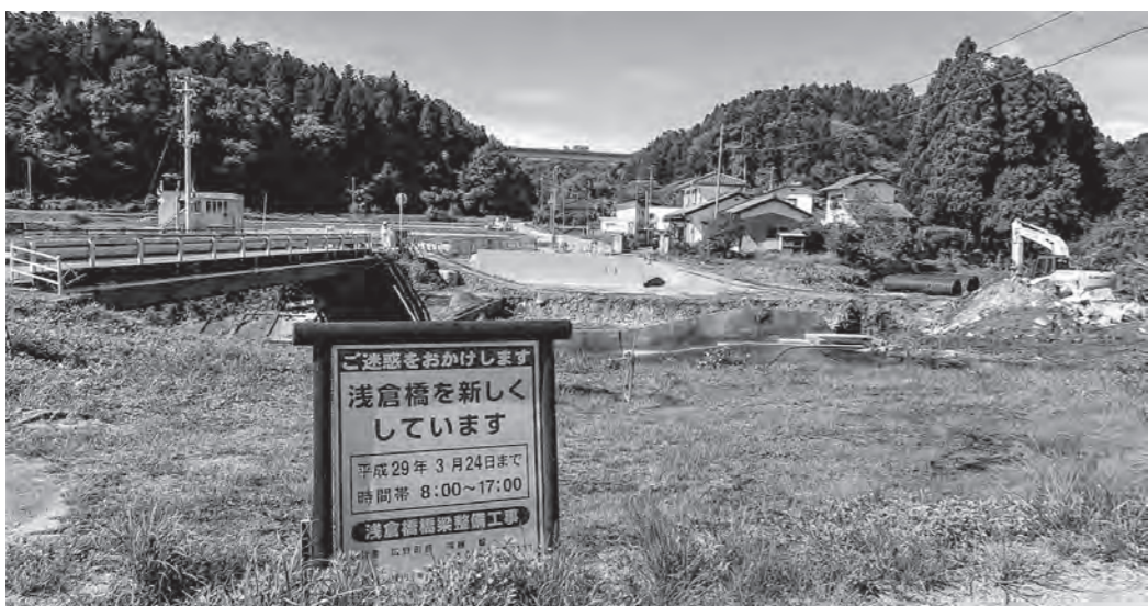
交通の利便性と安全確保のために（浅倉橋）
