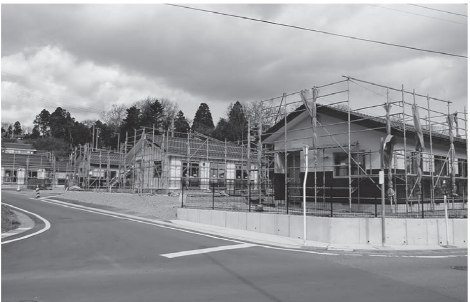
第2期災害公営住宅の整備が進む大平地区
