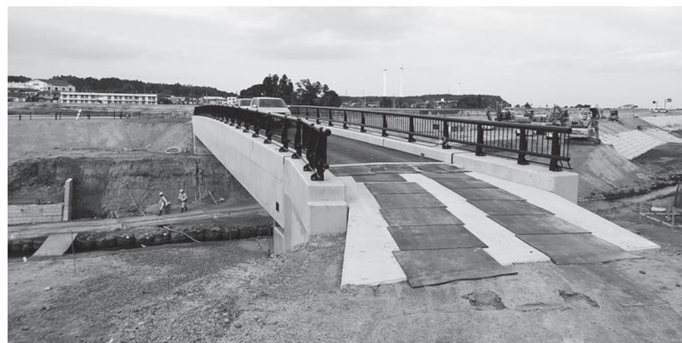
開通に向け進む工事（坊田橋）
