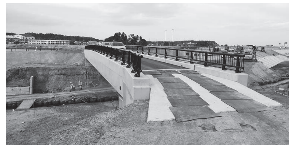
開通に向け進む工事（坊田橋）
