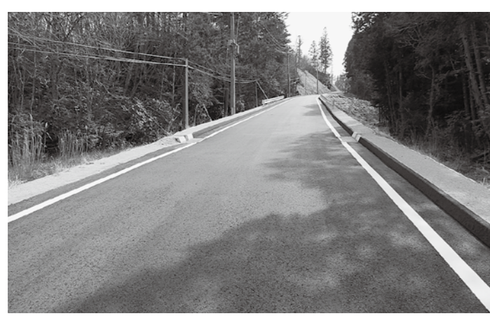
平成28年度に整備された北沢・東下線
