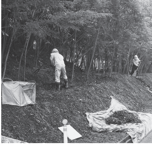
除染作業の様子
