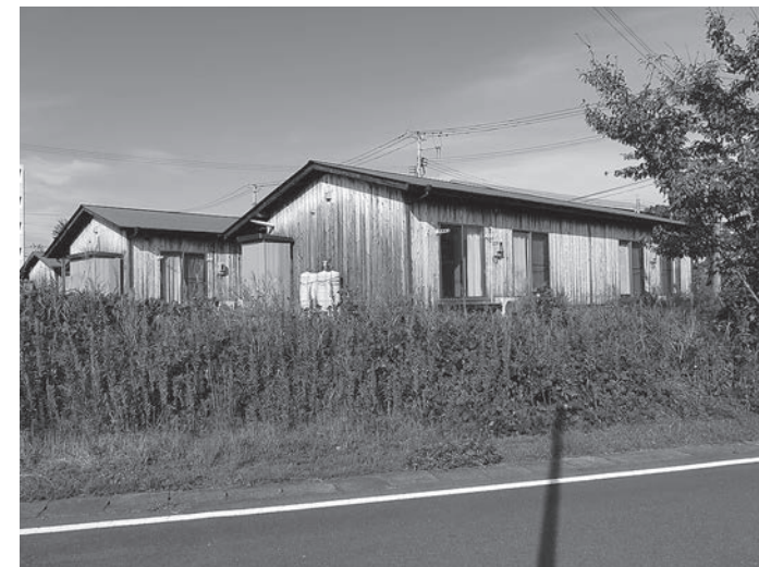
撤去を待つ下浅見川仮設住宅
