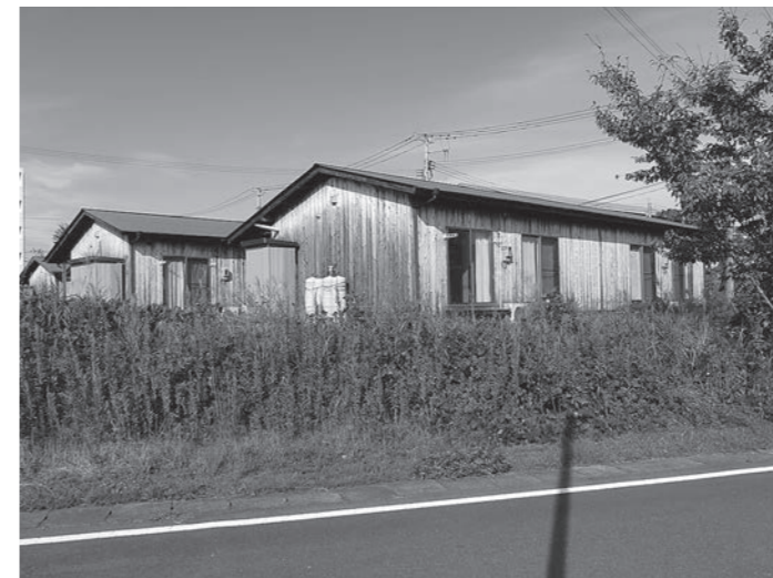
撤去を待つ下浅見川仮設住宅
