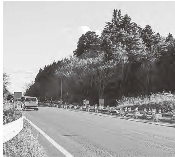
土取りをするために、国道交通省が仮設の右折レーンを整備（道の駅整備予定地）
