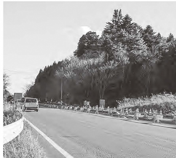
土取りをするために、国道交通省が仮設の右折レーンを整備（道の駅整備予定地）
