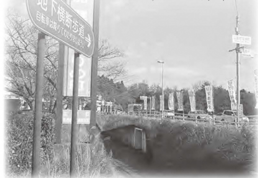
国道6号線を横切るトンネル
