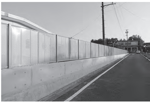
改修したフェンス（広野中学校）
