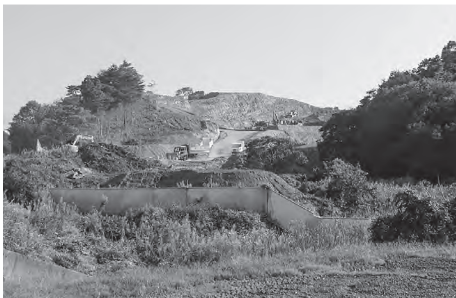
道の駅土取りの状況
