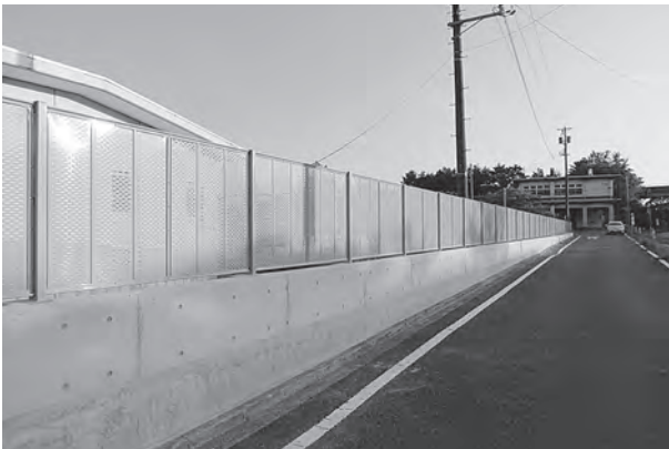
改修したフェンス（広野中学校）
