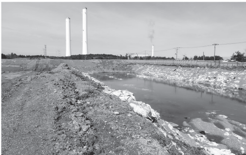
原形復旧する仮置場（下北迫）
