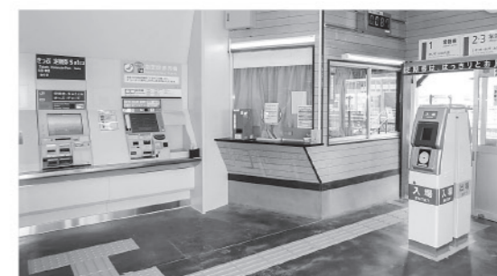
駅に設置された機器
