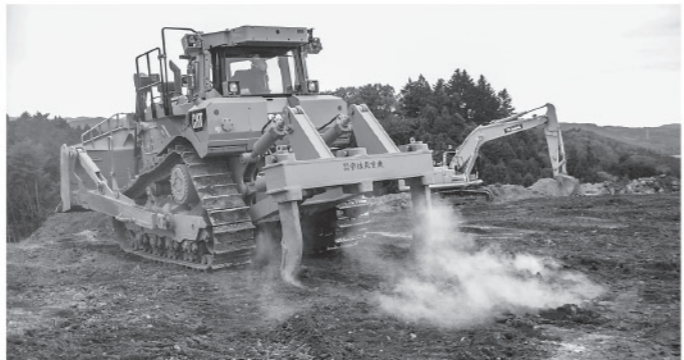
掘削が困難な岩盤（折木）
