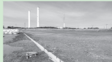
復旧が完了した1号基
