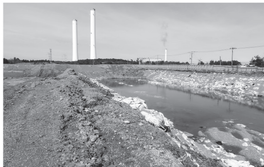
原形復旧する仮置場（下北迫）
