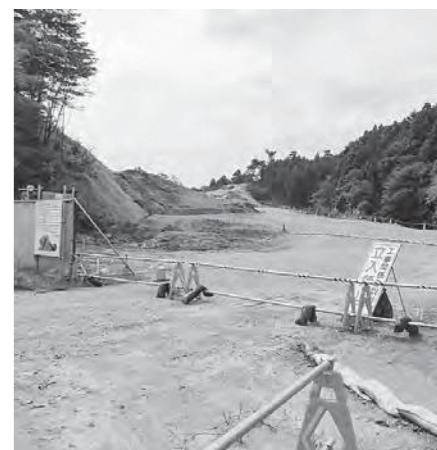
道の駅工事現場
