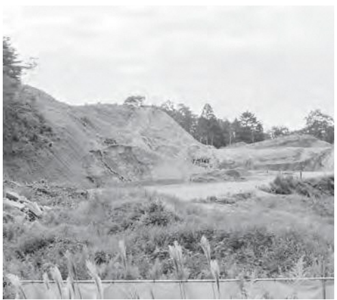
道の駅工事現場
