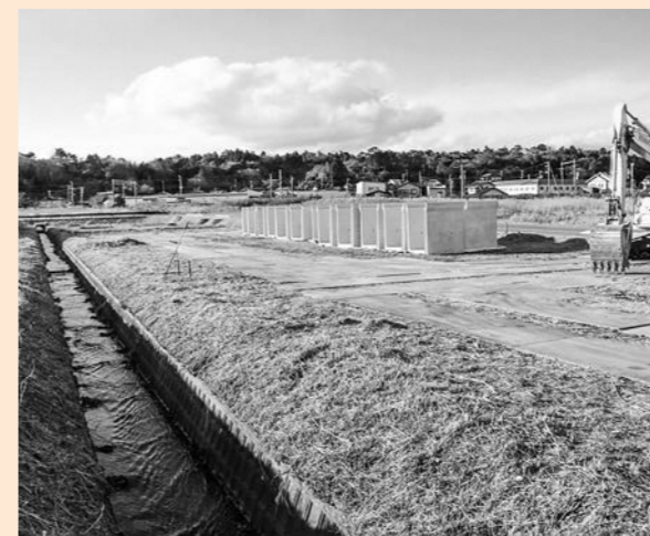
大きなU字溝に改修（下浅見川）
