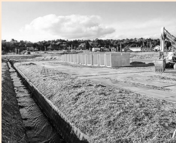
大きなU字溝に改修（下浅見川）
