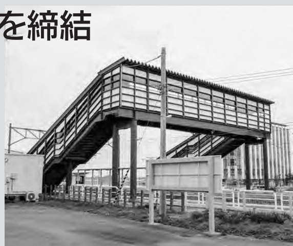
駅構内のこの線橋
