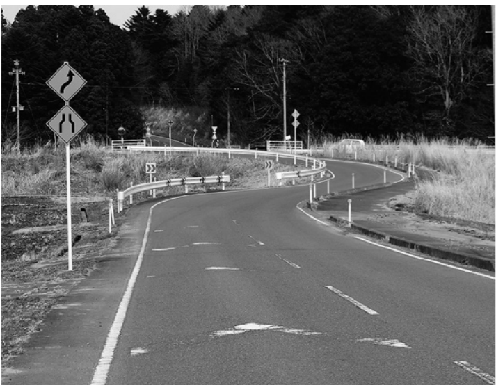
危険箇所等の改良を実施（ふるさと農道）
